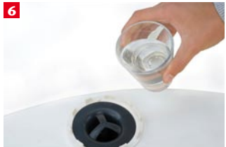
Anschließend den Geruchsverschluss in den Befestigungsring drücken und mit Wasser füllen. Danach den Laubfangkorb aufstecken und arretieren
