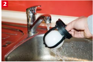
Rückstaeinheit und Dichtungen gründlich unter fließendem Wasser reinigen
